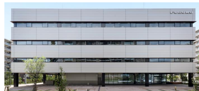
新研究開発棟 SOUTH WING
