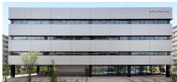
新研究開発棟 SOUTH WING
