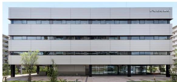
研究開発棟 SOUTH WING
