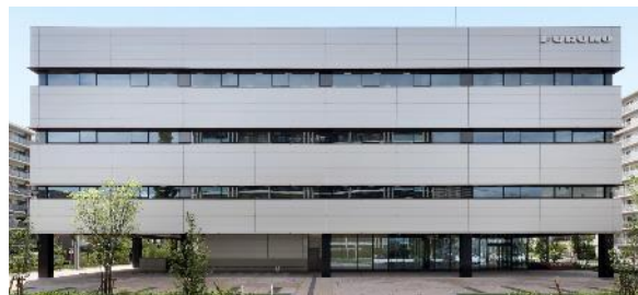
研究開発棟 SOUTH WING
