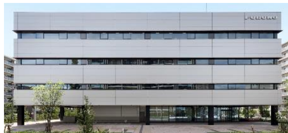
研究開発棟 SOUTH WING
